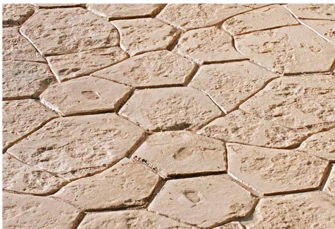
Artevia Empreinte est un béton imprimé prêt à l'emploi sur lequel est posé un moule à l'état frais, ce qui permet d'obtenir un aspect visuel choisi au préalable.
