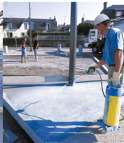
La technologie TMT (Time Mastering Technology) appliquée à la gamme Artevia est un concept de béton décoratif à durcissement rapide.
