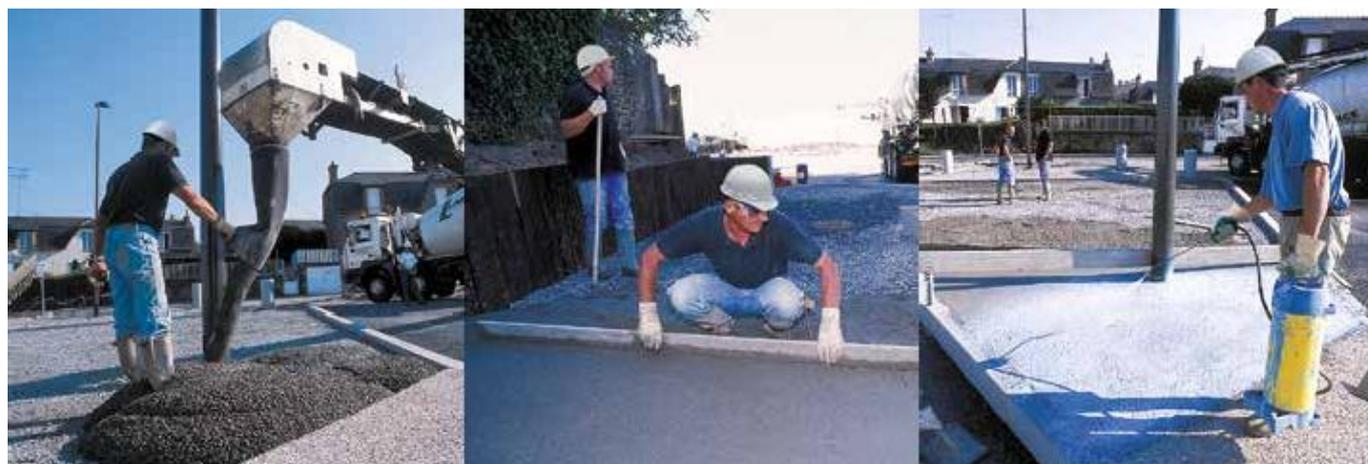
La technologie TMT (Time Mastering Technology) appliquée à la gamme Artevia est un concept de béton décoratif à durcissement rapide.
