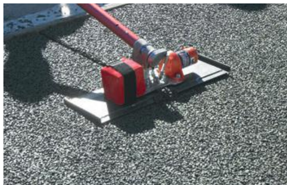
Photos 59 et 60 - Exécution des joints dans le matériau frais à l'aide d'un rouleau jointeur (à gauche) ou d'une jointeuse vibrante (à droite).
