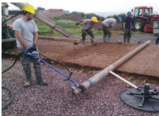
Photo 46 - Coulage du béton et réglage au « roller-striker ».
