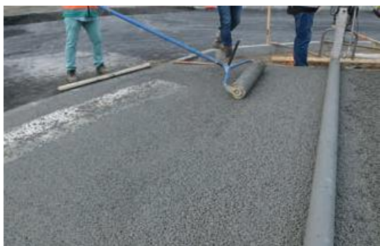
Photo 50 - Compactage au rouleau lesté.
