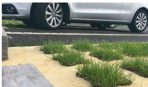
Photo 74 - Engazonnement des alvéoles (système ViaVerde®).
