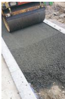
Photo 55 - Compactage du béton drainant.
