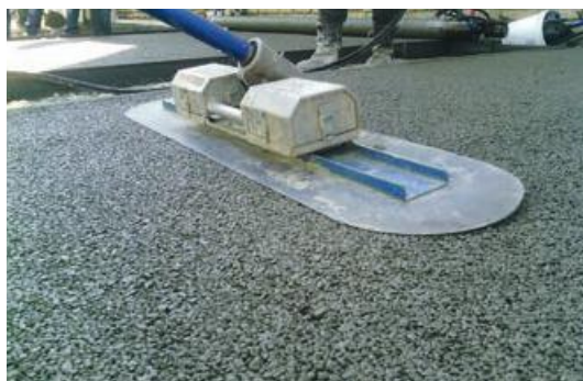
Photo 51 - Passage de la lisseuse vibrante.
