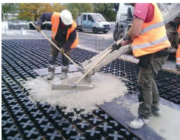
Photo 67 - Coulage du béton sur les moules Grasscrete®
