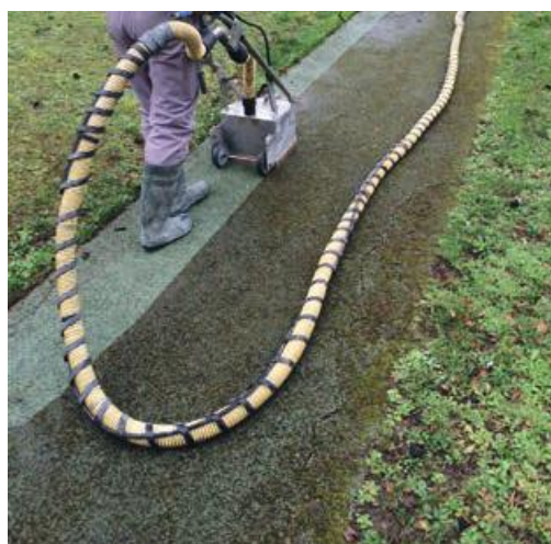
Photo 94 - Nettoyage par pression d'eau suivi d'aspiration.
