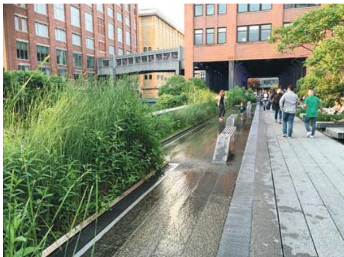
Photo 15 - Passage en produits préfabriqués avec brumisateurs.
