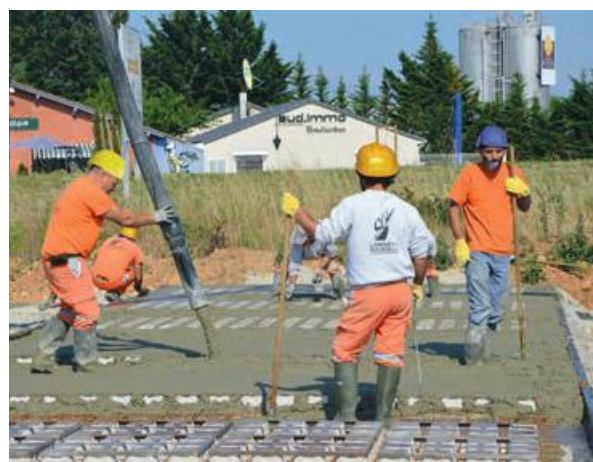
Photo 68 - Coulage du béton sur les moules ViaVerde®
