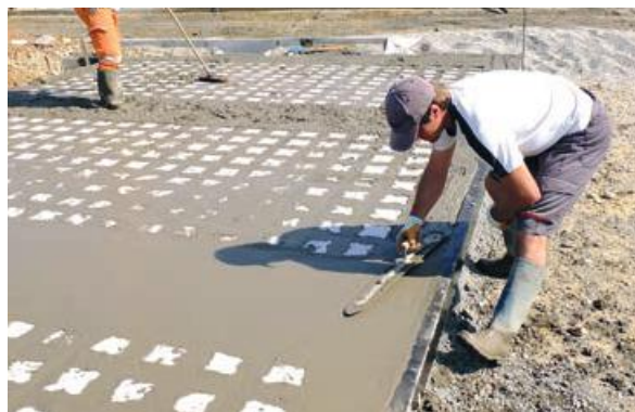
Photo 70 - Talochage du béton (système ViaVerde®)
