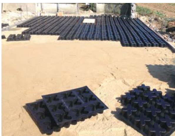
Photo 64 - Pose des moules (système Grasscrete®).
