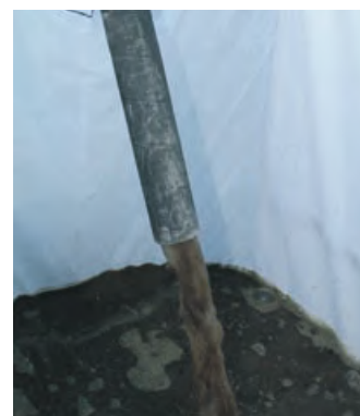
Photo 101 - La boue est récupérée dans des bacs.
