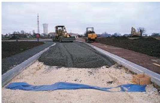
Photo 54 - Répandage du béton drainant à la niveleuse.
