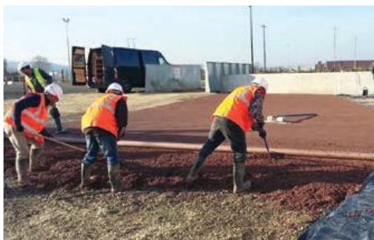
Photo 52 - Nivellement au roller-striker.
