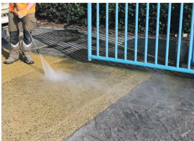
Photo 93 - Lavage au nettoyeur haute pression.
