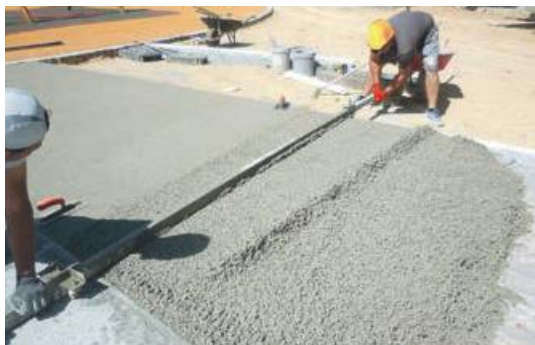
Photo 48 - Nivellement à la règle manuelle.
