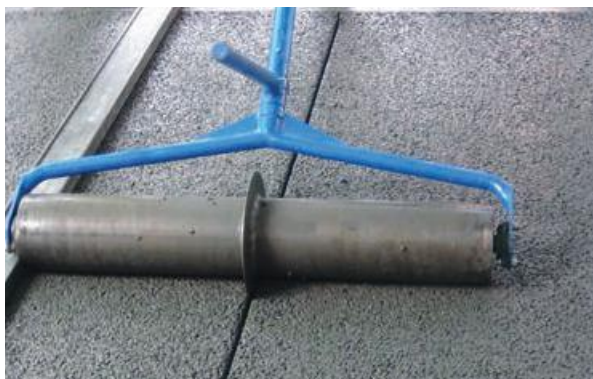
Photos 59 et 60 - Exécution des joints dans le matériau frais à l'aide d'un rouleau jointeur (à gauche) ou d'une jointeuse vibrante (à droite).
