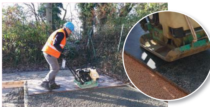
Photo 53 - Compactage au patin vibrant.
