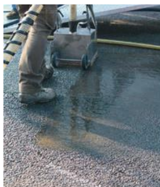
Photo 100 - Le nettoyeur aspire la boue produite.
