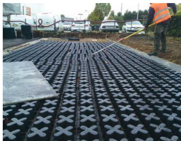
Photo 65 - Réalignement des moules (système Grasscrete®).
