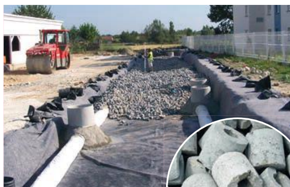
Photo 7 - Tranchée drainante utilisant le produit préfabriqué en béton Hydrocyl®.
