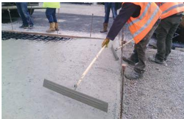
Photo 69 - Répandage à la raclette (système Grasscrete®)
