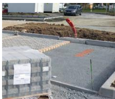
Photo 79 - Lit de pose en gravillons.
