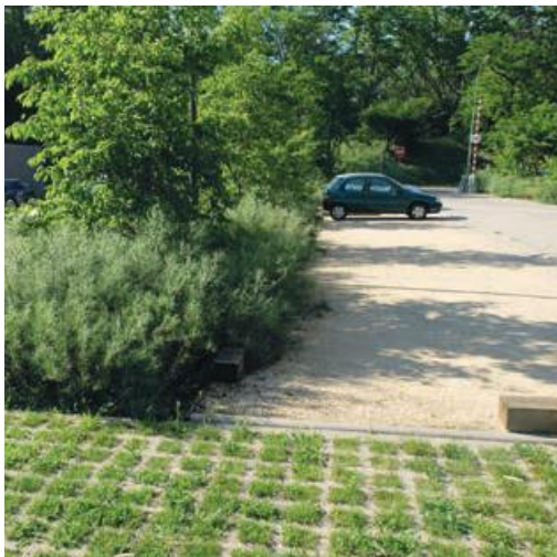
Photo 5 - Noue paysagère associée à un revêtement drainant.
